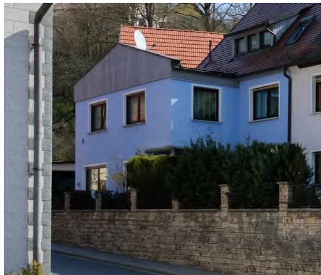
Flachdachanbau mit vorgesetzter Giebescheibe
